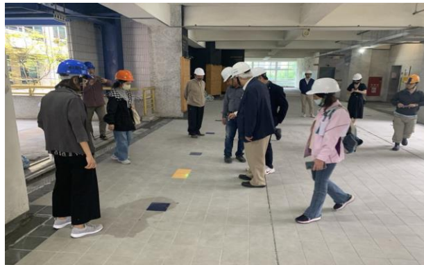
走廊梯間地坪及安全防墜改善工程
