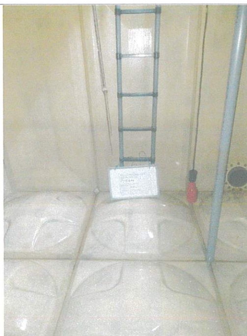
(文樓)水塔1清洗後
